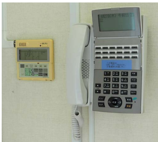
ファンコイル(ビルの空調(冷暖房)運転を補完。)
