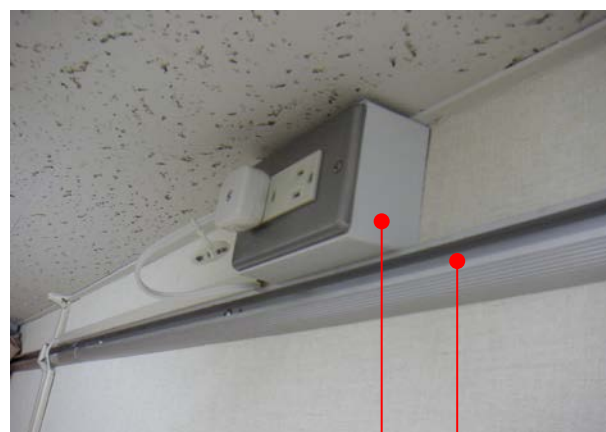
コンセント(壁上部)8箇所 ピクチャーレール (片側11m)
