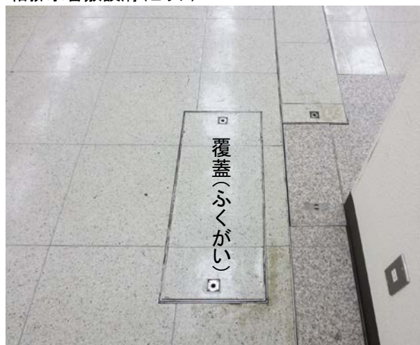
給排水管敷設溝(ピット)
